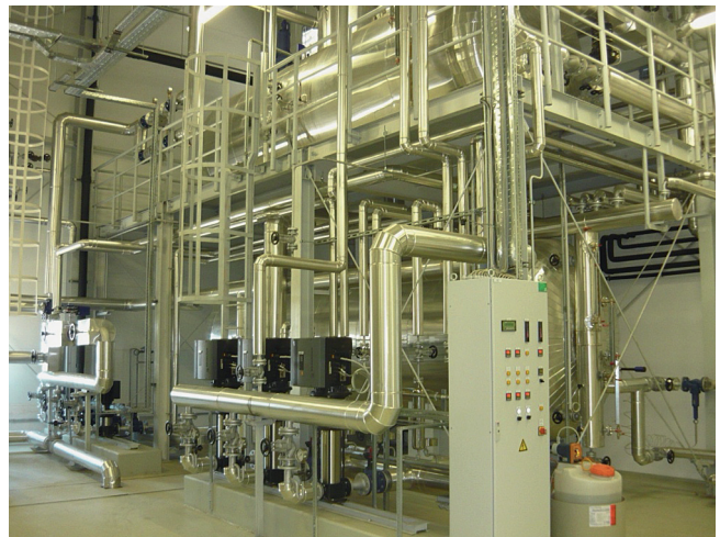
A gőzellátó rendszer tápvíz-tartálya és kevert pótvíz-tartálya a kazánházban
