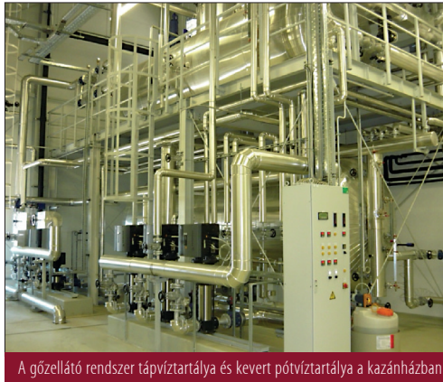
A gőzellátó rendszer tápvízirtartálya és kevert pótvízirtartálya a kazánházban
